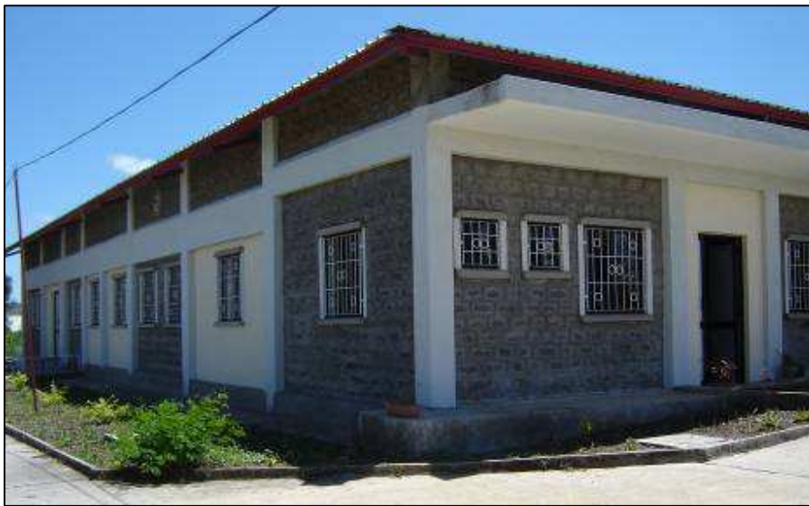
Fig.7: L'edificio che ospita la clinica ART al San Camillo
